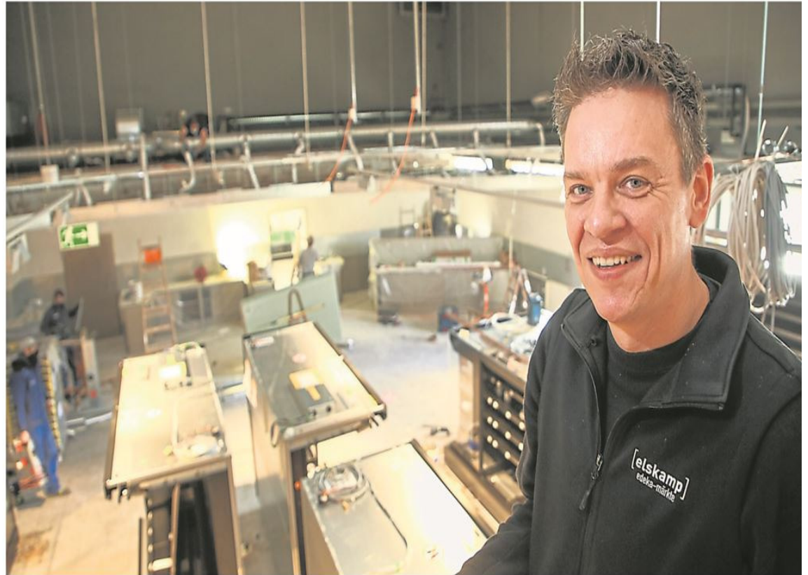
Von oben blickt Alexander Elskamp auf den Bereich des Supermarktes, der zurzeit umgebaut wird.
