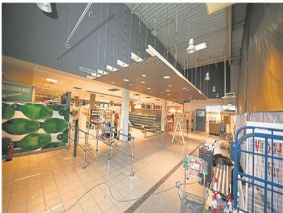
Der Eingangsbereich bekommt jetzt auch ein Obergeschoss. So entstehen zusätzlich 85 Quadratmeter Bürofläche.
